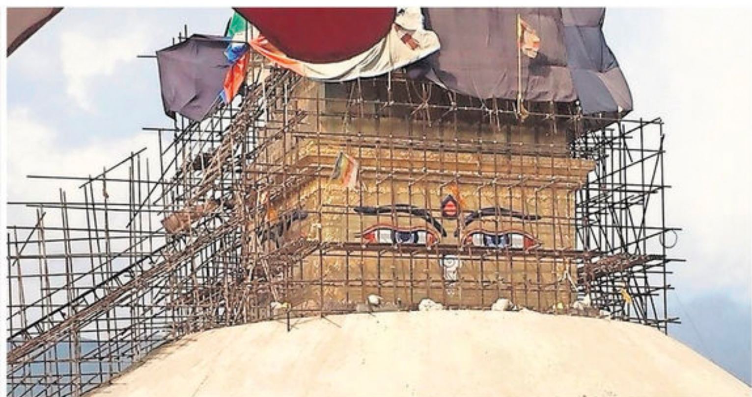
Buddhas Augen: Die Aufräum- und Aufbauarbeiten in Nepal sind allerorten voll im Gange – wie hier am berühmten Stupa in Bodnath in Kathmandu.
