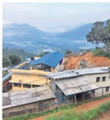
Mit Aussicht: Blick auf die Bauarbeiten am Hospital in Ampipal.
