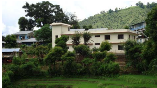
Das neue Mehrzweckgebäude im Amppipal Hospital
